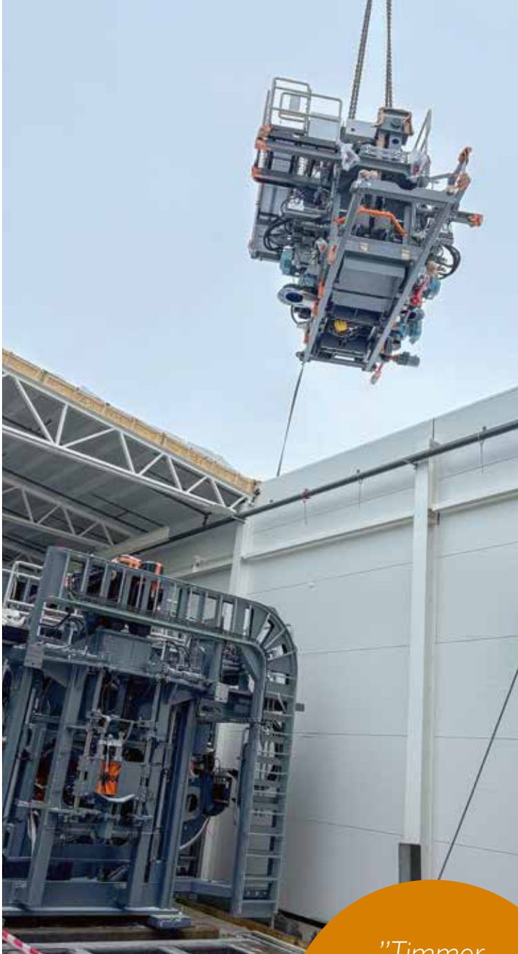
R200:ans inmatningsdel på väg ner i såghuset.
