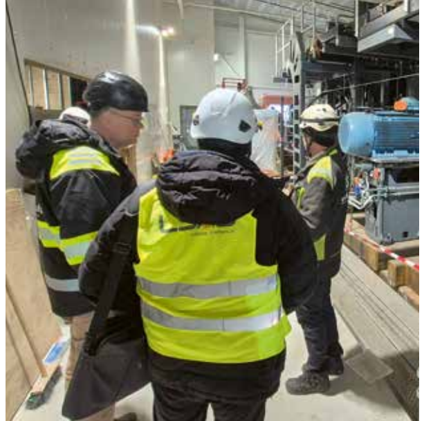
Paul Björnsson inspekterar installationen av R200:an.
