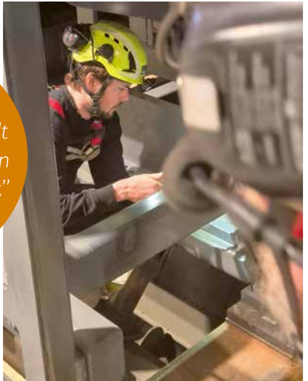
Anton Grödén, servicetekniker, HewSaw, justerar infästningen av rundvridaren.
